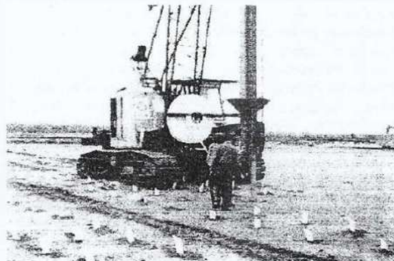
Gambar 2. Pemasangan Prefabricated Vertical Drain (PVD) di Stadion Utama Jakabaring
