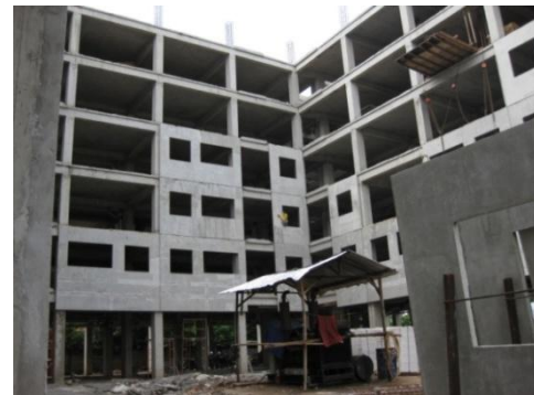
Gambar 18. Pembangunan Apartemen di Jakarta Menggunakan Panel Dinding Pracetak (Sumber: Nurjannah, 2009)
