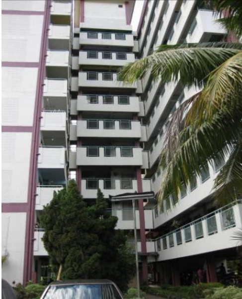
Gambar 15. Rumah Susun Sewa Sepuluh Lantai di Pasar Jum'at, Jakarta Menggunakan Panel Pracetak. (Sumber: Nurjannah, 2009)
