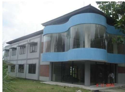
Gambar 12. Gedung Asrama Balai Irigasi di Solo Menggunakan Dinding n-Panel System (Sumber: Puslitbang Permukiman, 2010)
