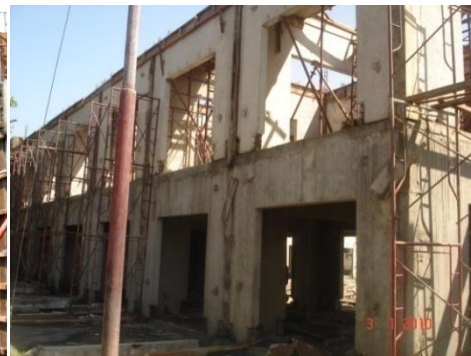
Gambar 10. Struktur n-Panel System Masih Didukung oleh Perancah (Sumber: Puslitbang Permukiman, 2010)
