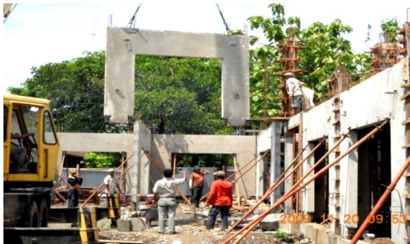
Gambar 9. Proses Pemasangan n-Panel System (Sumber: Puslitbang Permukiman, 2010)
