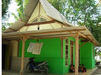
Gambar 2. – Rumah Ngibikan dengan teras yang dapat juga berfungsi mematahkan sinar matahari untuk pembayangan fasade sumber : Survey Lapangan, 2011
