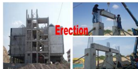
Gambar 14. Bangunan Asrama Universitas Diponegoro Menggunakan Sistem Join Balok Kolom L-10 dari PT Tribina Prima Lestari (Sumber: Lestari, P.T., 2007)
