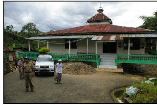
Gambar 16. Jaringan kabel untuk Masjid
