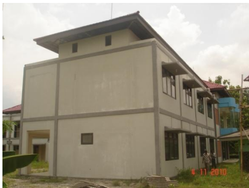
Gambar 11. Gedung Asrama Balai Irigasi di Solo Menggunakan Dinding n-Panel System (Sumber: Puslitbang Permukiman, 2010)
