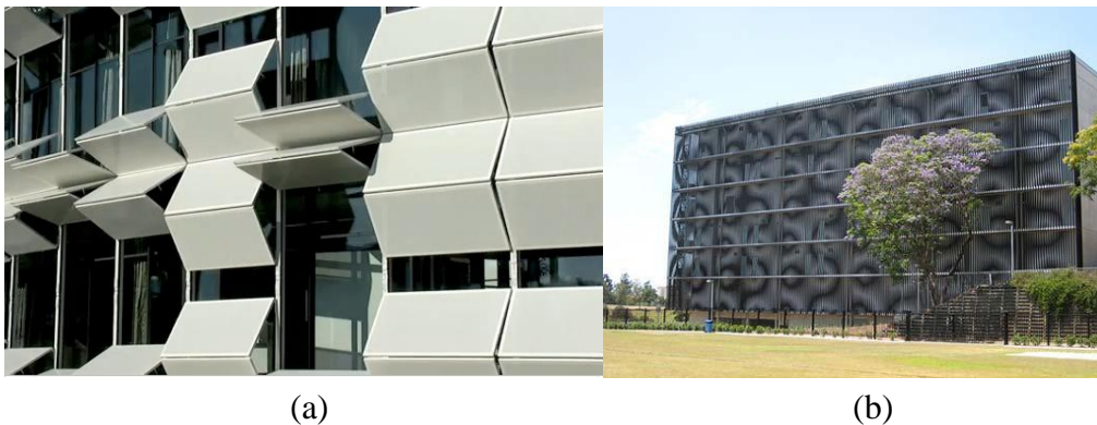
Gambar 4. Fasade dinamis dengan teknologi mekanik (a) fasade dinamis dengan menggunakan ilusi optik.
