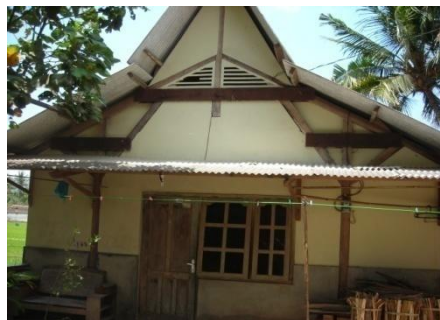
Gambar 1. – Rumah Rekonstruksi Pasca Gempa di Ngibikan Bantul yang modular dengan plafon yang tinggi dan memiliki ventilasi atap sumber : Survey lapangan, 2011.
