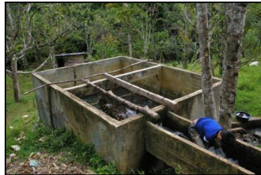
Gambar 10. Bak Kontrol Mikro hidro panjang 4 m lebar 3 m tinggi 2 m
