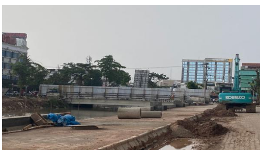
Gambar 1.3 Kondisi pengerjaan proyek revitalisasi Sungai Sekanak Lambidaro
