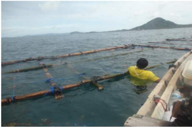
Gambar 18. Rakit bambu dipasang di laut lepas
