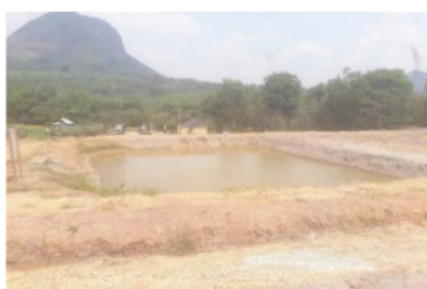
Gambar 8. Kolam pengendapan lumpur
