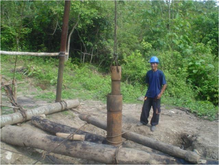
Gambar 3.8. Pengangkatan Tombros menggunakan Liyer
