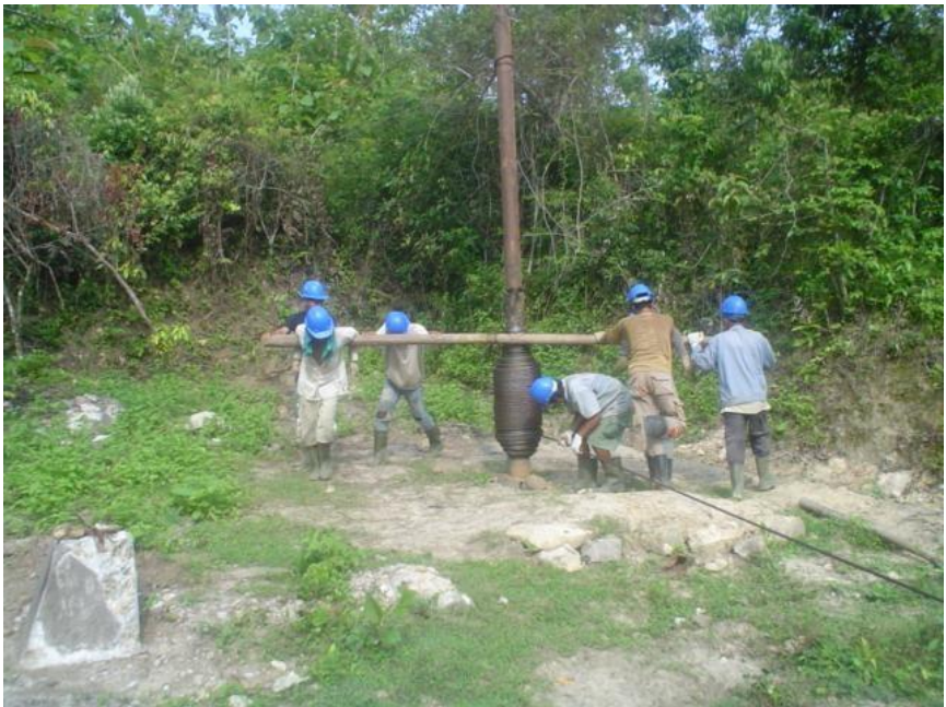
Gambar 3.7. Kegiatan re-opening Sumur Tua dengan Tombros
