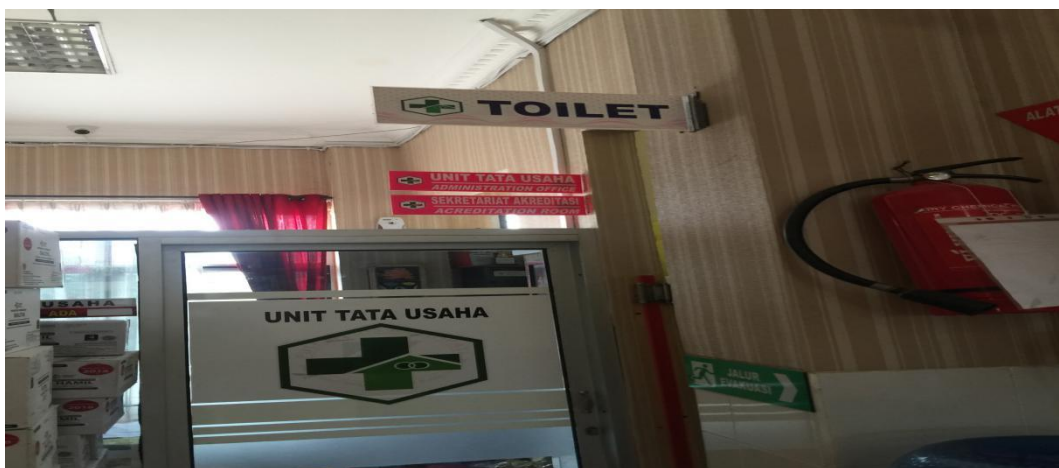
Gambar 2. Kondisi Toilet Puskesmas Kertapati Kota Palembang
