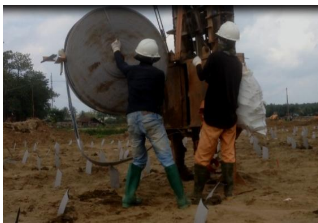
Gambar 4.11. Pemasangan gulungan PVD
