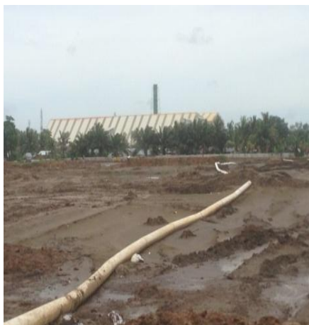
Gambar 4.7. Pipa PVC yang telah tersambung
