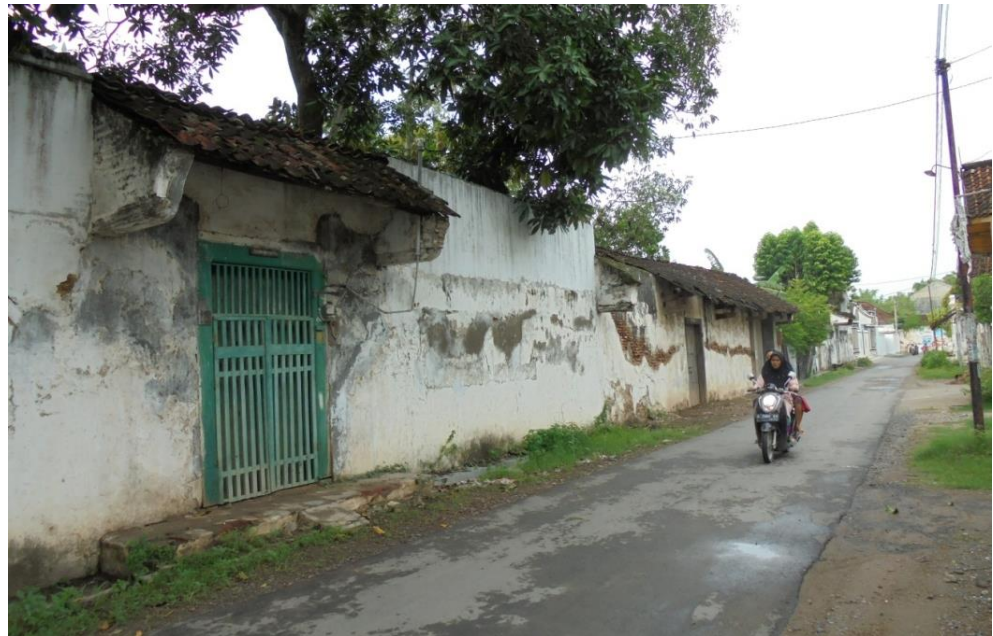
Gambar 1. Suasana jalan lingkungan kawasan permukiman di Jalan Karang Turi. Terlihat tembok-tembok pembatas rumah dengan gapura pintu yang seragam.
