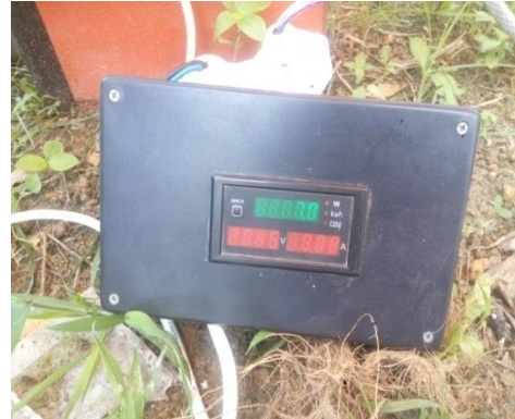
Pengukuran daya dengan AC power meter
