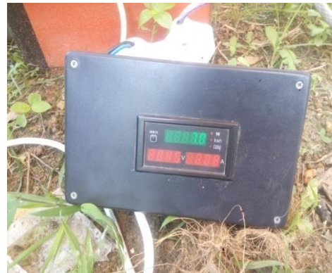
Pengukuran daya dengan AC power meter
