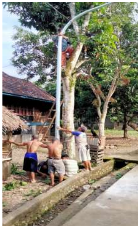
Gambar 1. Pemasangan lampu jalan
