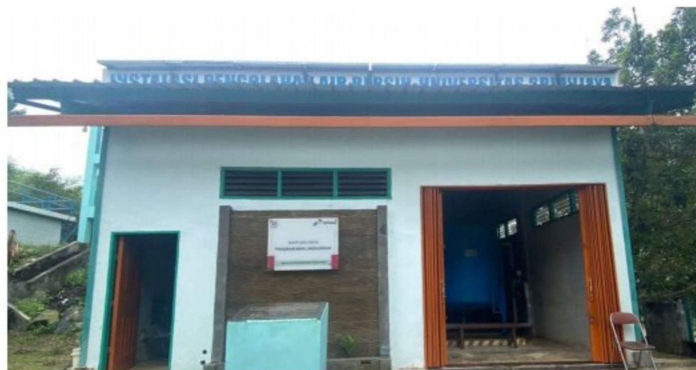
Gambar 4. 12 Instalasi pengolahan air bersih Universitas Sriwijaya
