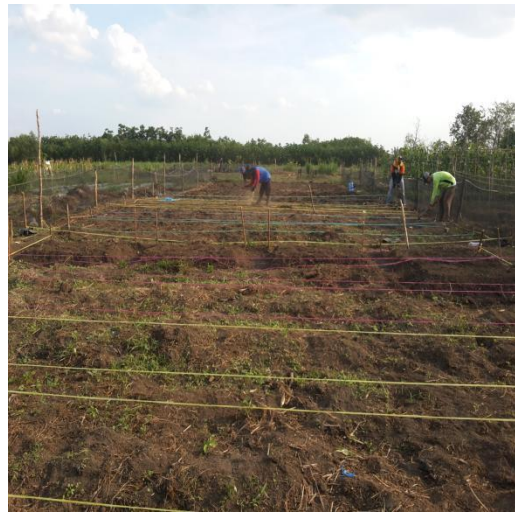
2. Pengolahan lahan/ land clearing
