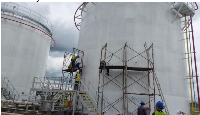
Gambar 1. Tangki Penyimpanan Avtur yang dibangun dengan Proses pengelasan
