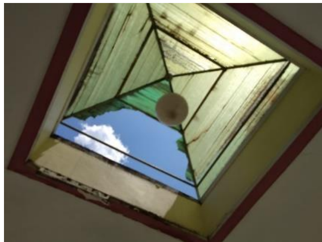
Gambar 1-1 Kondisi terkini Gedung Kesenian
