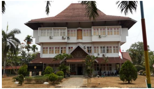
Gambar 43. Gedung Dekanat FISIP UNSRI Sumber : Dokumentasi, 2014
