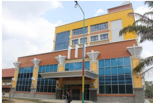
Gambar 45. Gedung Pusat Kajian Batu Bara FT UNSRI Sumber : Dokumentasi, 2014
