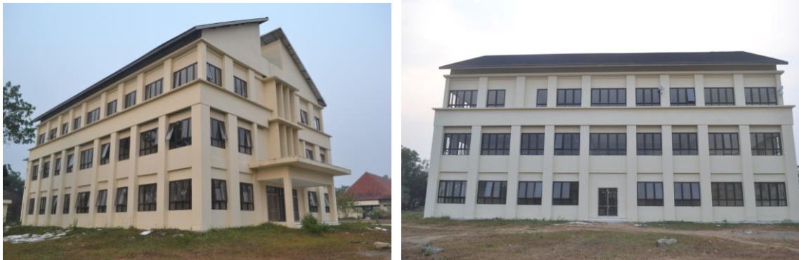
Gambar 34. Gedung baru FKM Unsri Sumber : Dokumentasi, 2014
