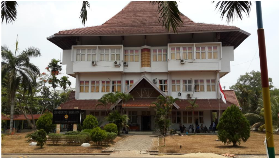
Gambar 26. Gedung Dekanat FISIP Unsri Sumber : Dokumentasi, 2014
