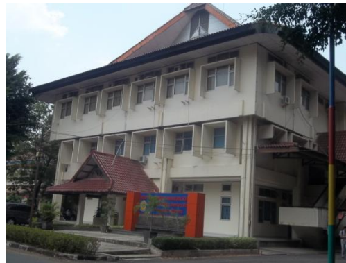
Gambar 42. Gedung Dekanat FMIPA UNSRI Sumber : Dokumentasi, 2014
