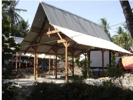
**Gambar 5.** – Bangunan rumah Ngibikan yang memanfaatkan material yang ada di lokasi seperti pemanfaatan kayu kelapa dan batu alam serta bambu
