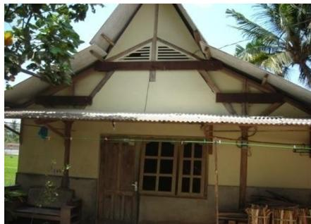
Gambar 1. – Rumah Rekonstruksi Pasca Gempa di Ngibikan Bantul yang modular dengan plafon yang tinggi dan memiliki ventilasi atap
