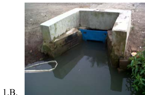
ibuangan, 1B pintu tersier pada saat pemasukan air (suplai)
