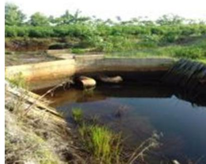
Gambar 3.7. Sistem operasi pintu air untuk opsi drainase terkendali
