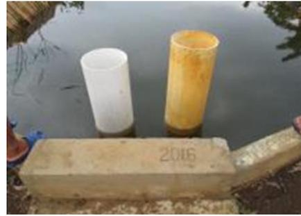
Gambar 3.6. Pintu air pada saat menahan air (a) dan pintu beroperasi drainase terkendali (b)
