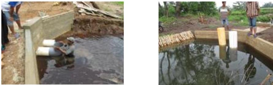
Gambar 3.11. Pipa leher angsa di operasikan untuk menahan air
