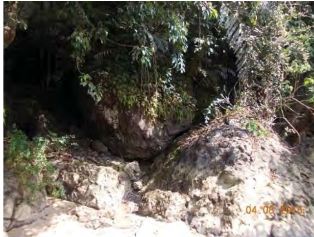
Gambar 10. Kondisi boulder yang rawan bergerak (menggeling) jika menerima getaran. Kenampakan ini berada diantara target bak penampung dan power house .
