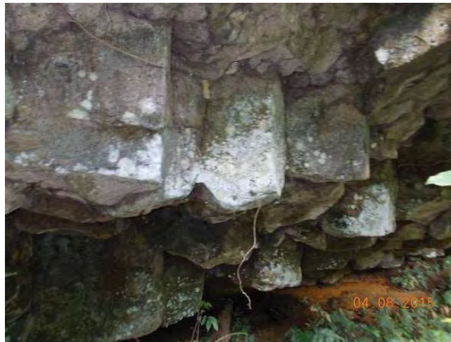
Gambar 5. Struktur columnar joint yang labil.
