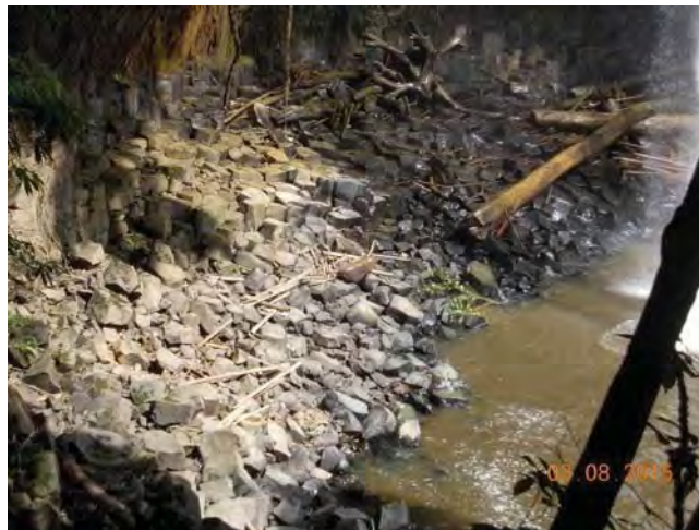
Gambar 9. Columnar joint yang collaps pada kontak dengan struktur masif. Berada di gua di balik air terjun, columnar joint selalu terisi air melalui celah di setiap bidangnya.
