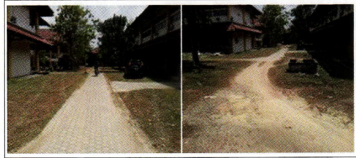
Gambar 13. Kondisi material jalur pedestrian FT Unsri
