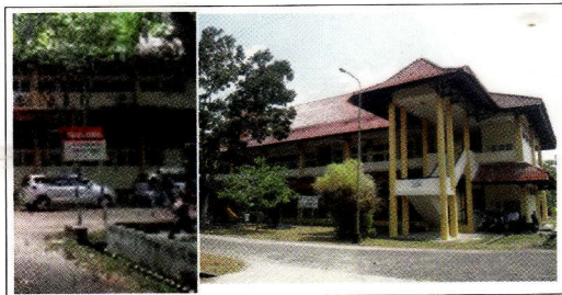
Gambar 15. Penempatan signage yang mengganggu pedestrian dan visual enclosure kurang tercipta dari jalan di depan bangunan lab Teknik Pertambangan
