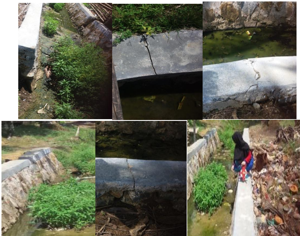
Gambar 1 Kondisi Pembangunan Saluran Drainase
