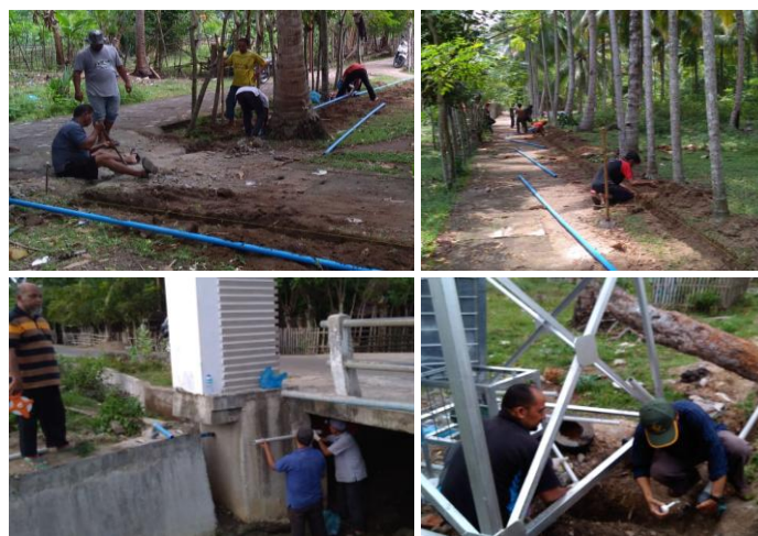
Gambar 4. Pemasangan jaringan perpipaan
