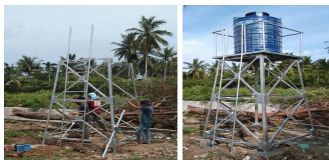
Gambar 5. Pembuatan reservoir induk
