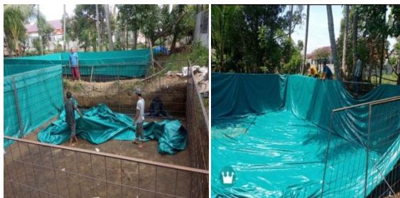
Gambar 4. Pemasangan Kerangka besi dan terpal disekeliling Kolam
