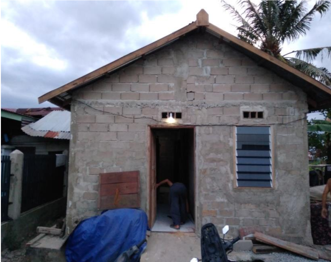
Gambar 1.2 Kondisi rumah sesudah berjalannya Program BPS di Kota Palembang Sumber : Dinas Perumahan Rakyat dan Kawasan Permukiman Kota Palembang
