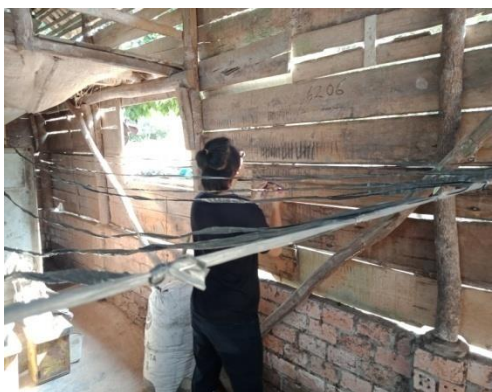
Pemasangan tali untuk titik pengukuran
