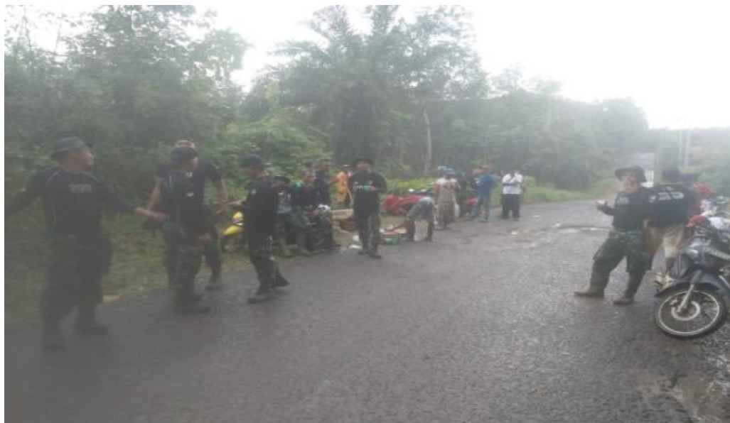
Gambar. 31 Perbaikan Jalan di Kecamatan Gandus
