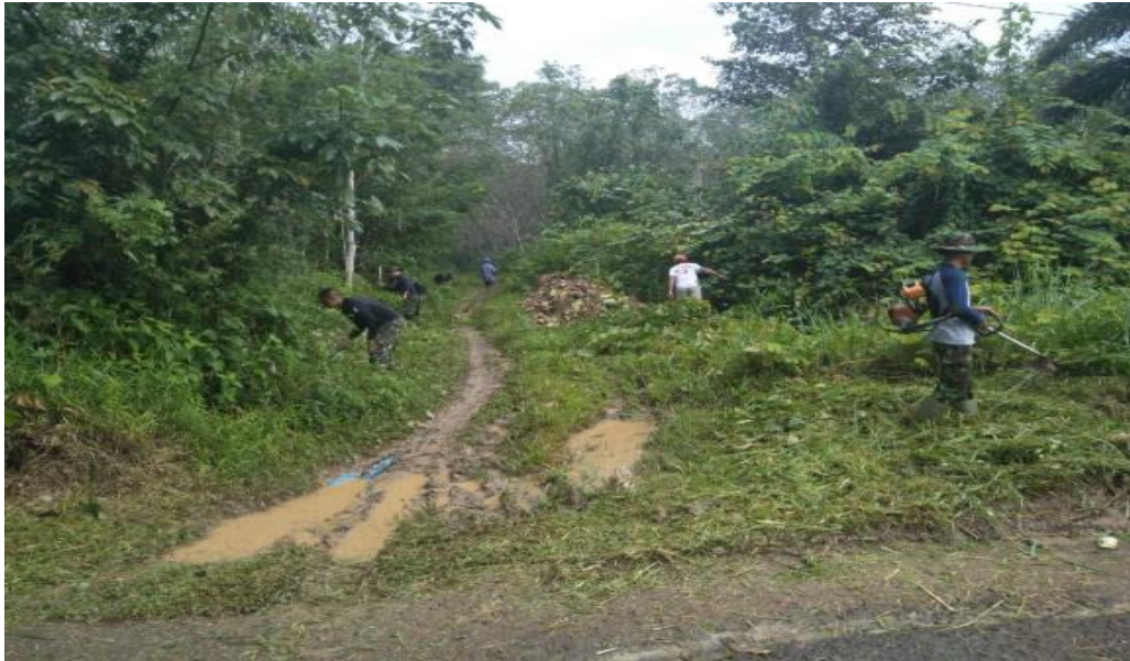
Gambar. 30 Perbaikan Jalan di Kecamatan Gandus
