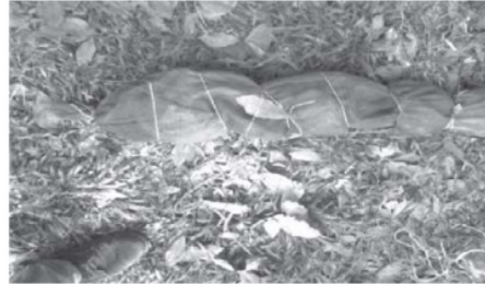
Gambar 5. Desain sabut kelapa untuk drainase bawah tanah
