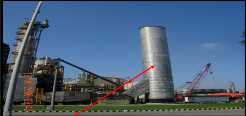
Stack gas buang Pusri IB diisolasi guna mencegah pendinginan ekstrim dari angin
