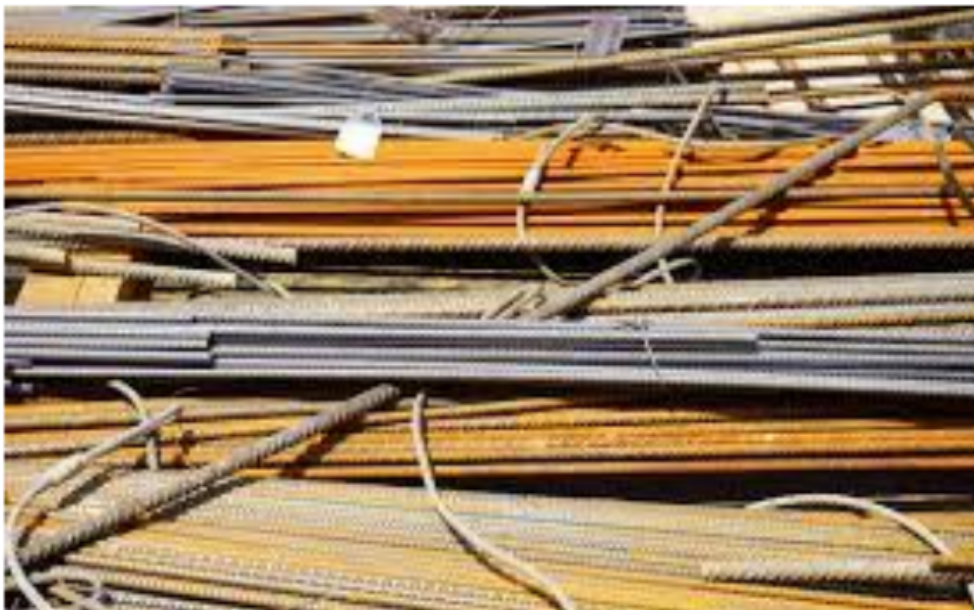
Baja Tulangan Terkorosi Sebelum Konstruksi
