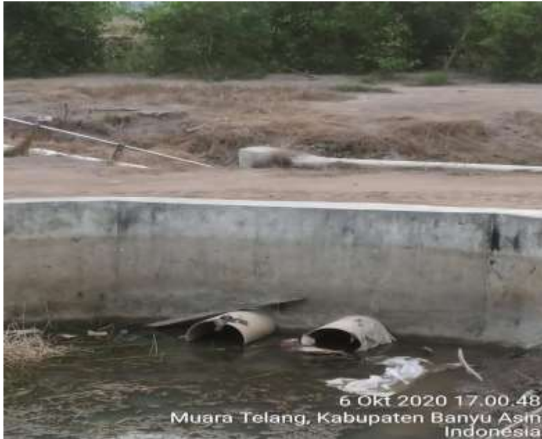
Gambar 2.9. Model pintu air dari paralon di lahan tipe C Telang Jaya Delta Talang I Banyuasin
