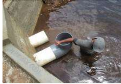
Gambar 5.13. Proses pembangunan pintu air leher angsa di Air Sugihan 2016.
