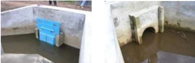
Gambar 6.1. Model pintu air tipe kelep bahan fiber di lahan tipe A (operasi drainase)
