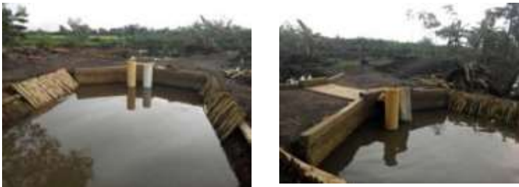
Gambar 6.14. Pintu air pada saat menahan air fase vegetatif padi
