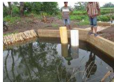
Gambar 5. 14. Operasi pintu air pipa leher angsa sebagai retensi air.
