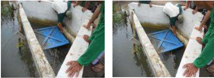
Gambar 5.11 Pintu kelep bahan papan di desa Telang Karya Telang I Banyuasin
