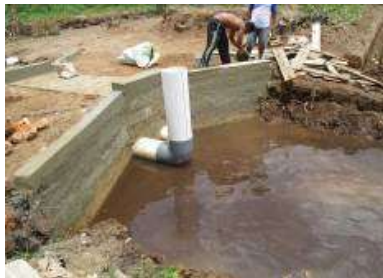
Gambar 5. 14. Operasi pintu air pipa leher angsa sebagai retensi air.
