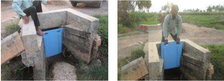
Gambar 5.16. Operasi pintu sorong pada saat menahan dan memasukan air
