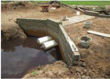
Gambar 5.13. Proses pembangunan pintu air leher angsa di Air Sugihan 2016.
