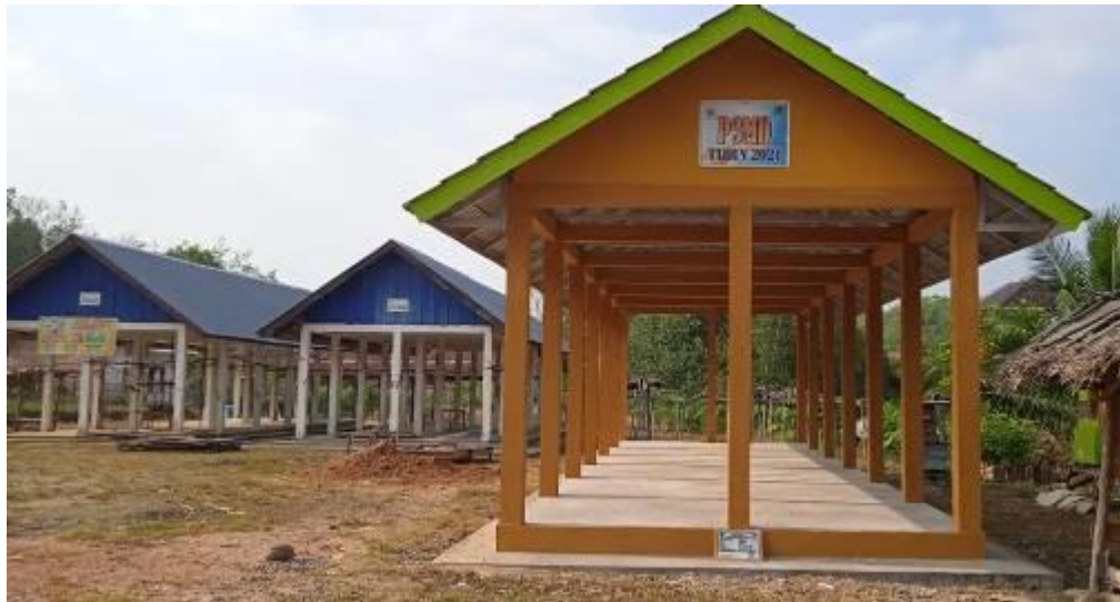
Gambar 6 Pembangunan Los Pasar Desa Benuang
