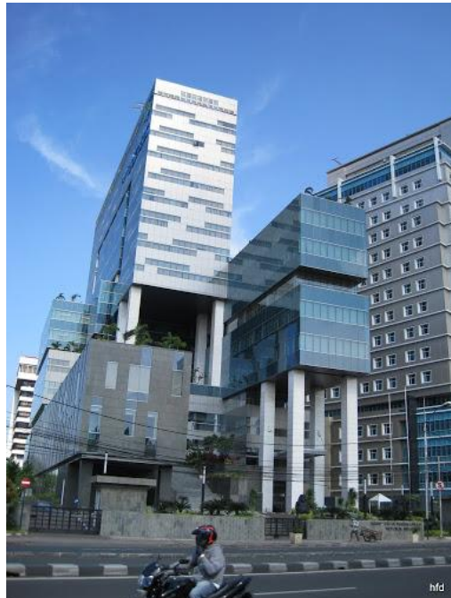
Gambar 2.32. Ekspos kolom-kolom langsing untuk memberi kesan monumental pada bangunan tetapi meningkatkan potensi soft story pada kolom tersebut (sumber : http://lh5.ggpht.com/_BuyHB_UQftY/S6DLycY7uNI/AAAAAAAAABV4/ds3GchVwtj4/IMG_1248.JPG ).
