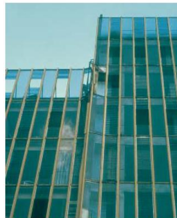
Gambar 2.13. a). Gempa Yogya 2006, pounding di expansion joint (sumber : Elnashai et al. 2006), b). Gempa Mexico 1985, pounding bangunan yang serupa (sumber : Bachmann 2003).
