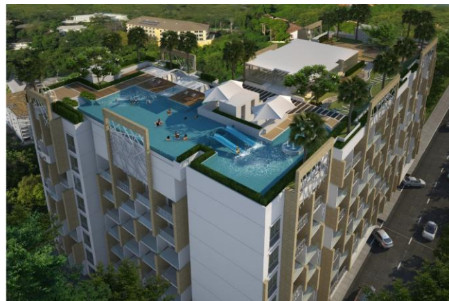
Gambar 2.41. Perletakkan kolam renang di sebagian roof top akan menimbulkan potensi P Delta effect dan torsion effect (sumber : http://heights-holdings.com/images/wp/gallery-water-park-3d-building-side-view-top.jpg ).
