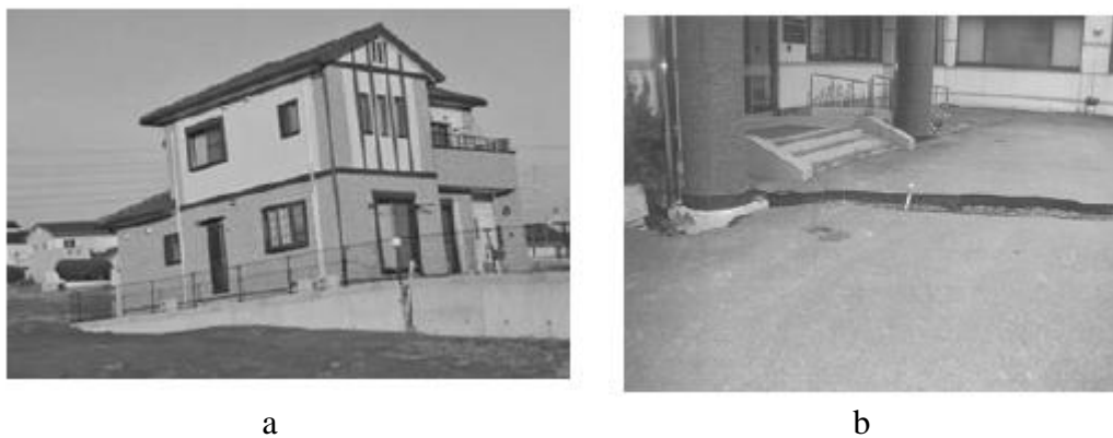
Gambar 2.5. Kerusakan tanah a). Tilting , b). Crack (sumber : JIA & JASO 2012)
