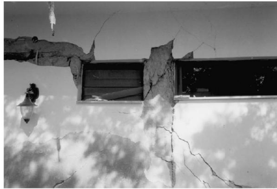
Gambar 2.12. Gempa Yunani 1996, short column akibat interupsi dinding di kolom (sumber : Penelis & Penelis 2014)
