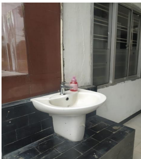
Gambar 1. Wastafel di depan pintu masuk
