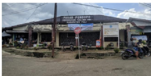
Gambar 4.1 Bangunan Pasar Pendopo
