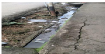
Gambar 4.7 Drainase Di Pasar Pendopo
