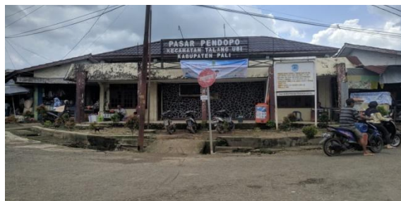
Gambar 4.1 Bangunan Pasar Pendopo
