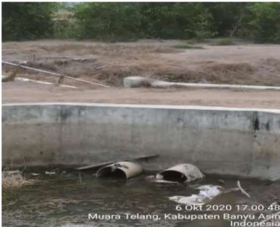
Gambar 2.9. Model pintu air dari paralon di lahan tipe C Telang Jaya Delta Talang I Banyuasin
