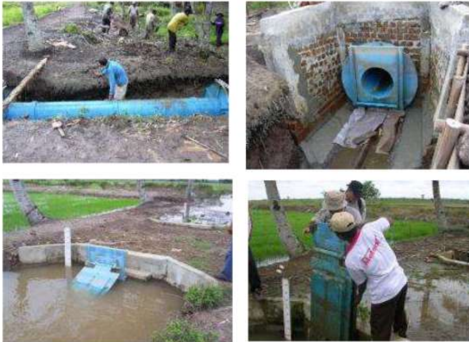
Gambar 5.7. Pintu air tipe kelep bahan fiber kombinasi dengan gorong-gorong.
