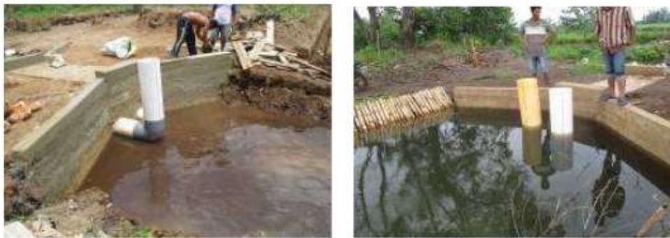
Gambar 5. 14. Operasi pintu air pipa leher angsa sebagai retensi air.
