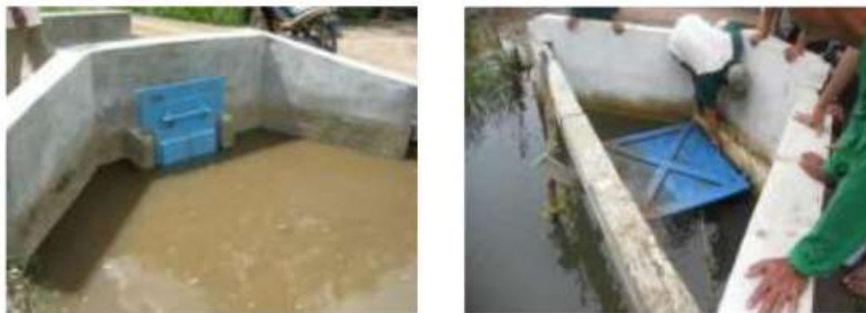
Gambar 4.9. Pintu tipe kelep sangat sesuai di lahan tipe A. Bahan fiberglas (a) dan bahan kayu papan (b)
