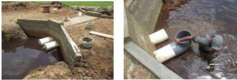
Gambar 5.13. Proses pembangunan pintu air leher angsa di Air Sugihan 2016.
