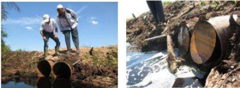
Gambar 5.18. Pintu air kelep berbahan baku kaleng drum bekas di perkebunan sawit
