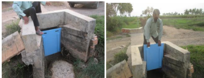
Gambar 6. Pintu sorong bahan papan dan teknik operasi
