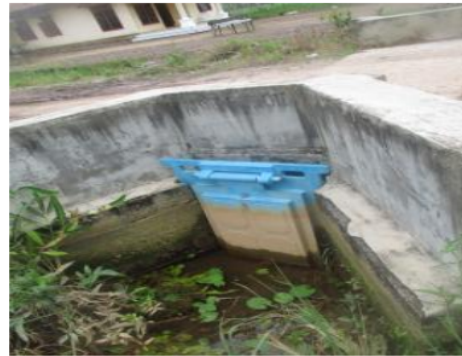
Gambar 5. Operasi pintu kelep untuk pembuangan air di awal pertumbuhan
