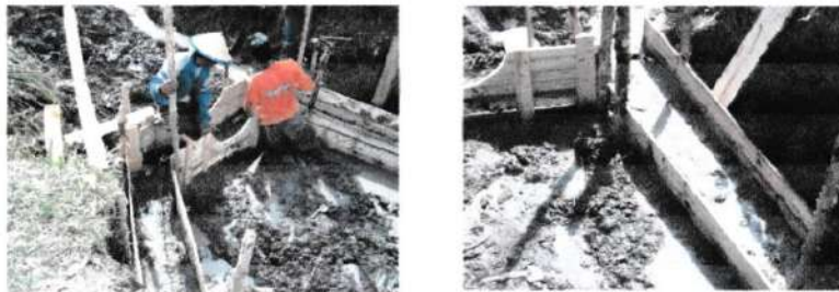
Gambar 2. Proses pengecoran untuk konstruksi gorong-gorong
