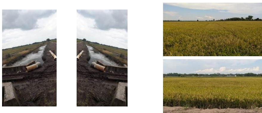
Gambar 4.12. Kondisi pintu air terbuka dan padi sudah siap panen Juni 2020.
