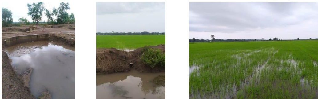
Gambar 4.16. Kondisi operasi pintu air dan pertumbuhan padi tanggal 29 Oktober 2020
