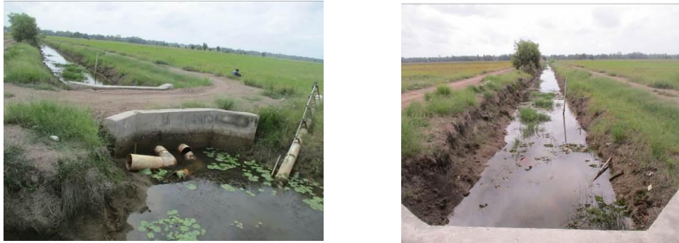
Gambar 4.12. Operasi pintu terbuka dan air disalurkan mengalami penurunan (Agustus)
