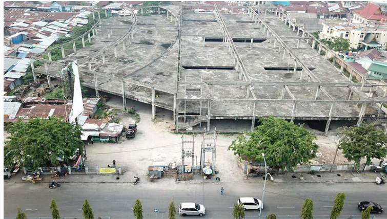
Gambar 1. 1 Eksisting bangunan Pasar Cik Puan Kota Pekanbaru (Sumber: Riaupos, 2019)
