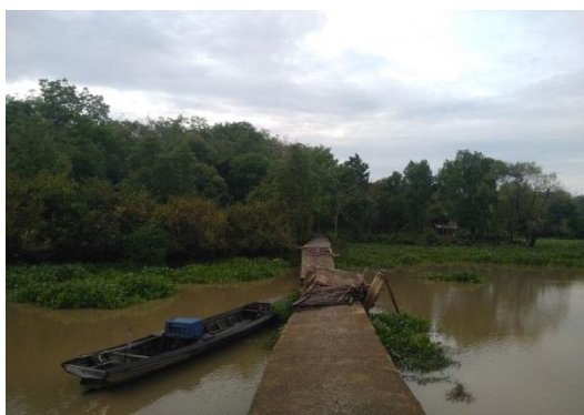
Gambar 1.2. Jembatan menuju lokasi peternakan kerbau di Desa Cinta Jaya
