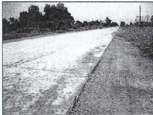
Gambar 2. Ruas Jalan Palembang-Tanjung Api-Api
