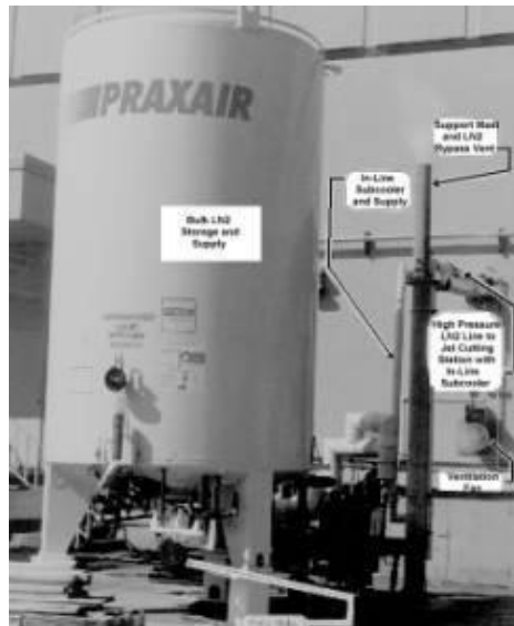
Gambar 3.12. Tabung Nitrogen cair pada Abrasive Cryogenic Jet (ACJ) dan sistem alirannya.
