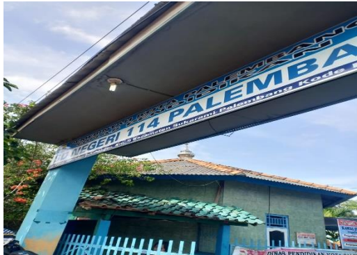
Tampak gapura depan SD Negeri 114 Palembang
