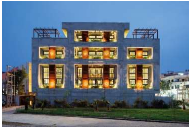
Gambar 15. Tampak Samping Bangunan
