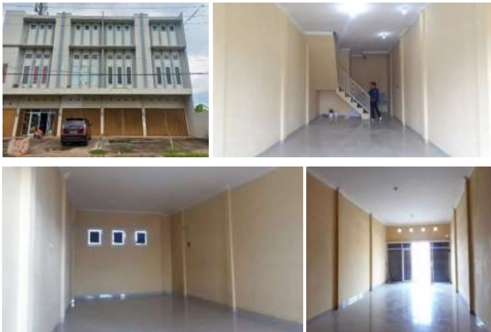
Gambar 1 Kondisi Ruko yang Kurang Nyaman untuk dijadikan Kantor
